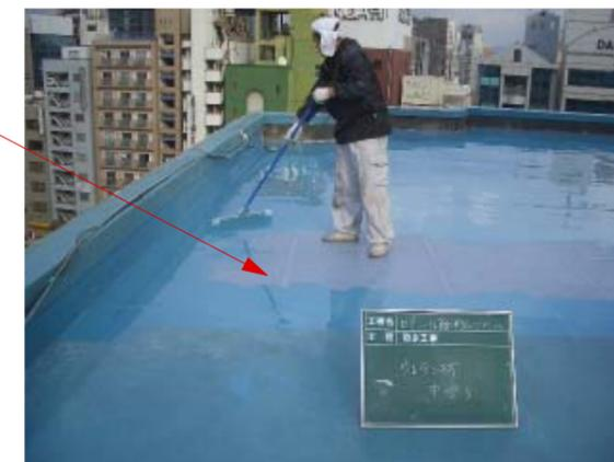
ウレタン塗膜防水は、ポリイソシアネートを主成分とする主剤と、ポリオールを主成分とする硬化剤を現場にて攪拌し、躯体に塗布して施工する防水です。不定形材料のため下地の形状に馴染み易く、水密性の高い連続皮膜が得られるため、屋上をはじめとした各種部位への防水に適しています。
